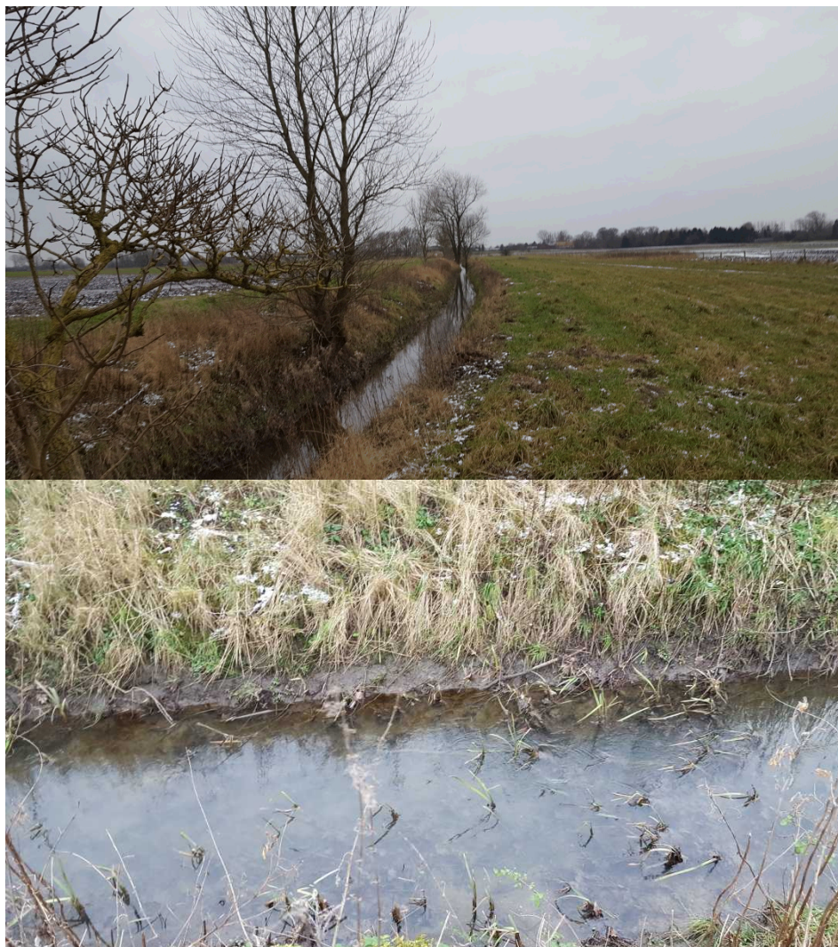
Figur 3.4: Øverst: foto af en karakteristisk delstrækning fra den øverste 1 km af den målsatte strækning med kanaliseret tværsnitsprofil og ringe fald. Nederst: udsnit af vandløbsbund med blød bund og tilgroning med pindsvineknop.
